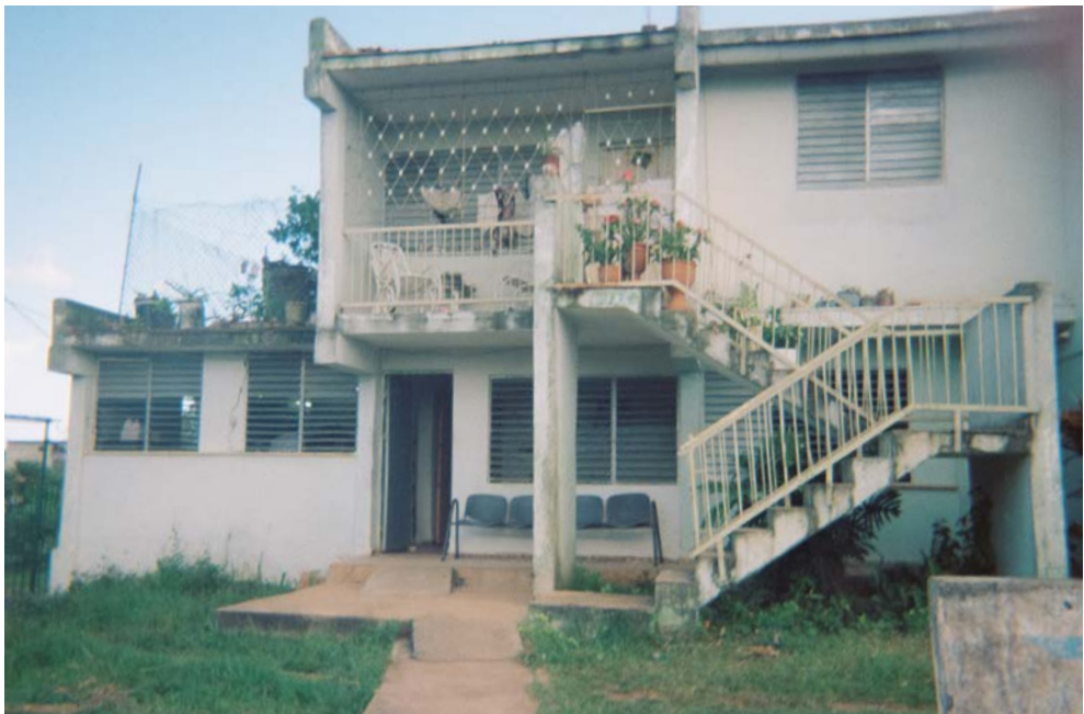
Construcció d'un consultori: a la planta baixa, el consultori i la casa de la infermera, i a la primera planta, la casa del metge, el médico .
